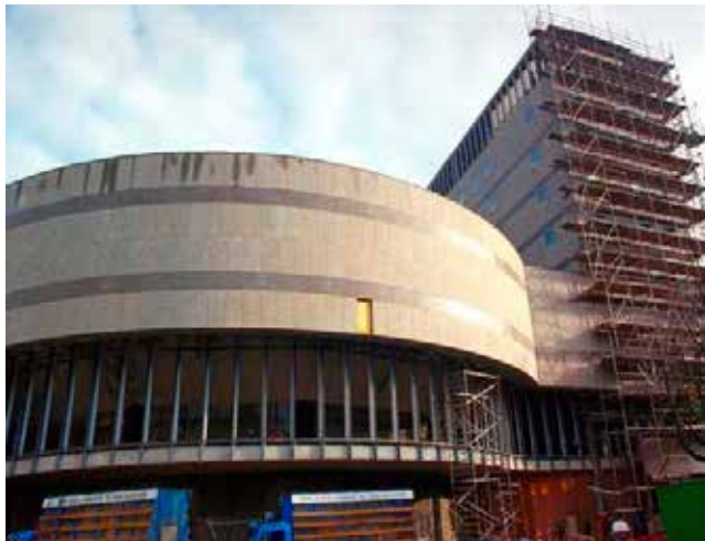
Nieuwbouw Tweede Kamer in aanbouw
